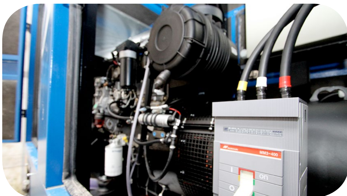
Como os dados e informações encaminhados pelos órgãos e entes públicos ficam armazenados em data-centers, a estabilidade no fornecimento de energia é fundamental
